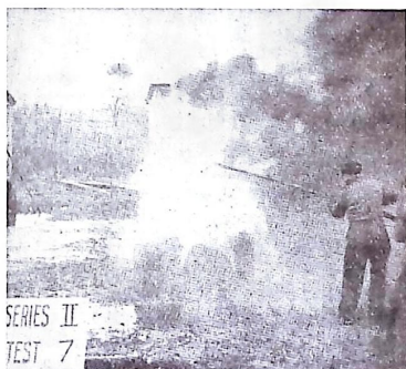
Fig. 4. Förlängningsrör med sönderpiskad stråle. Utmärkt resultat oberoende av trycket så länge strålen täcker hela oljeytan.
